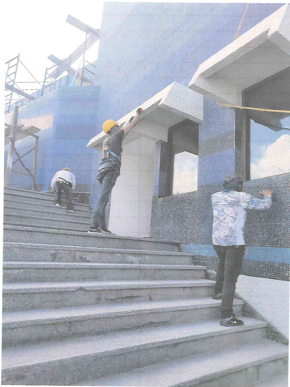
Limpieza y desinfección de teselas en segmento A5 de la fachada Oriente.
